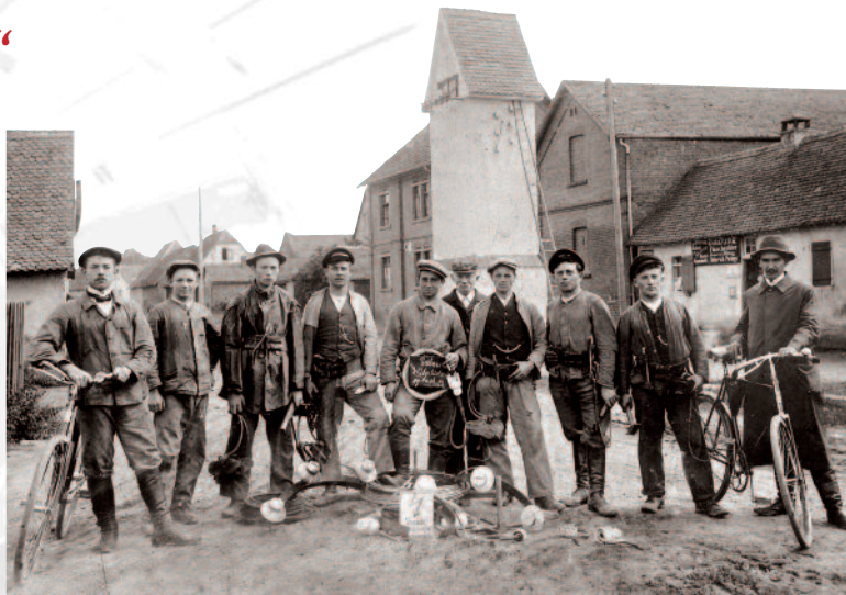
Bau des Ortsnetzes Höchst-Oberliederbach durch Mitarbeiter der Main-Kraftwerke AG, 1912
