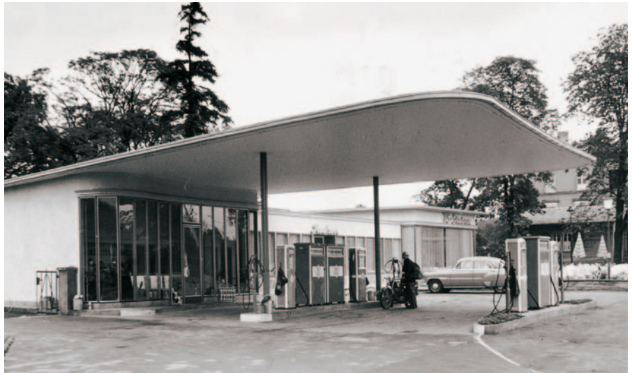
BV-Großtankstelle mit angeschlossener Gaststätte und Gartenlokal PS-Stuben in der Rheinstraße 75 in Darmstadt, 1952
