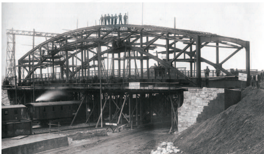
Bau der Bahnüberführung in Weinheim a.d. Bergstraße. Donges-Monteur posieren auf dem Brückenbogen, 1912
