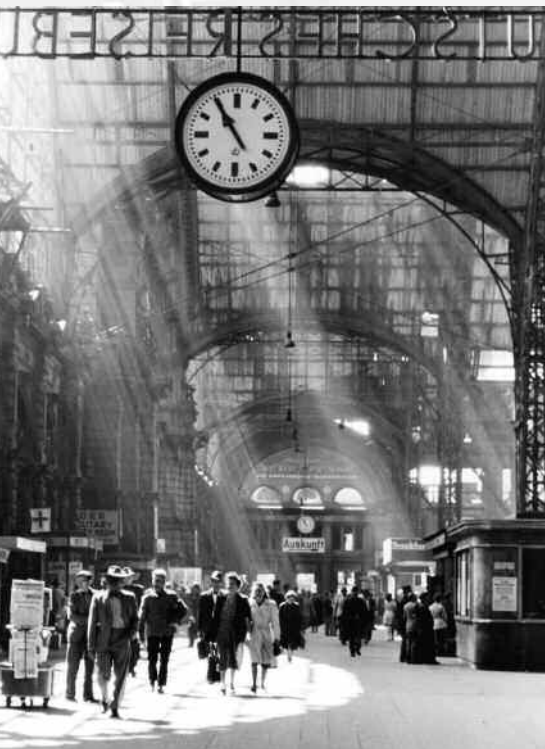
Der Frankfurter Hauptbahnhof 1951
